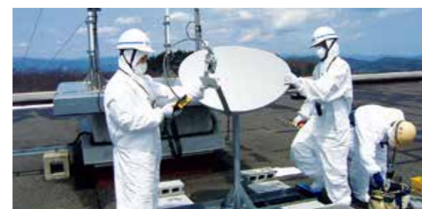
被災地で衛星通信のアンテナを設置する様子
