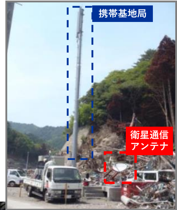
災害現場の携帯移動基地局
