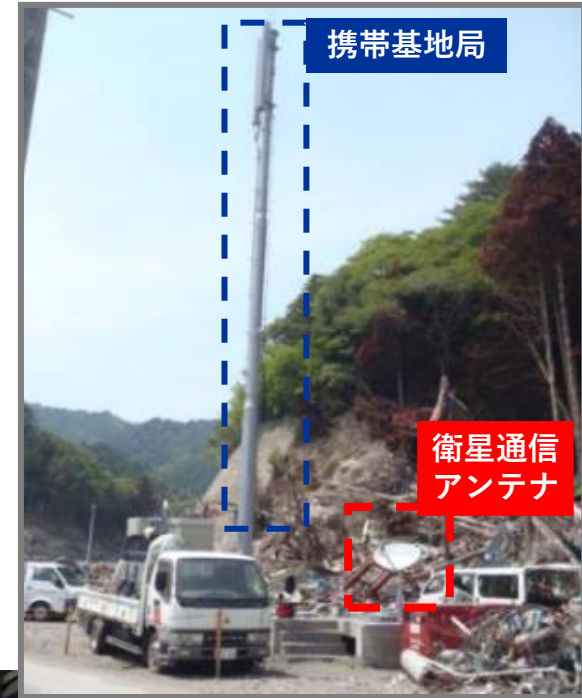
災害現場の携帯移動基地局
