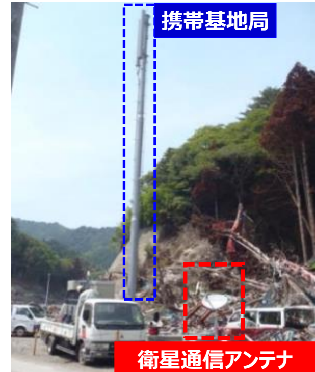
災害現場の携帯移動基地局
