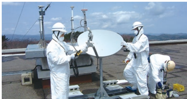
被災地で衛星通信のアンテナを設置する様子
