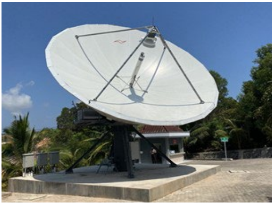
左：Teleglobal の敷地内に構築した JCSAT-1C 向けゲートウェイ局/バタム島
