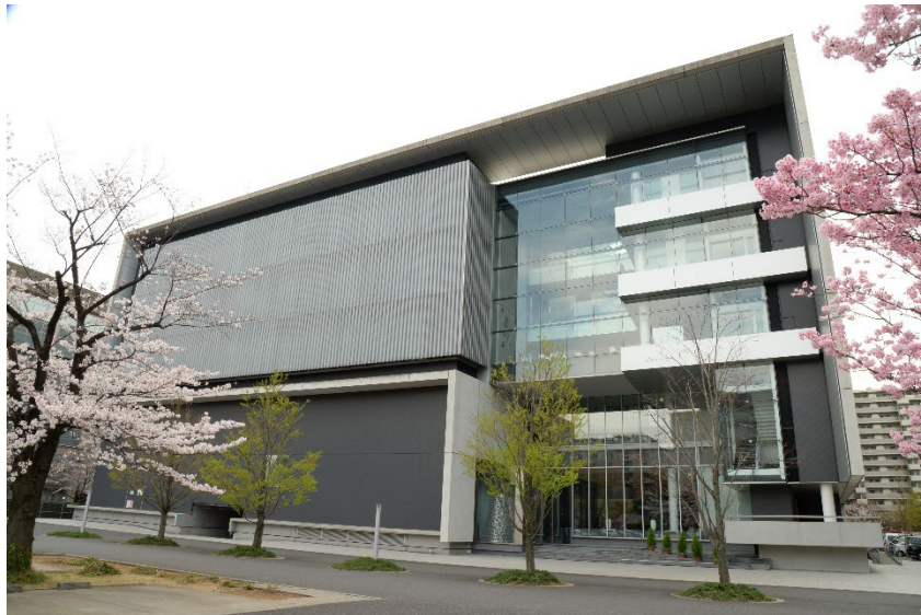
スカパー東京メディアセンター (Tokyo Media Center)
