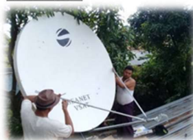
アンテナ設置
