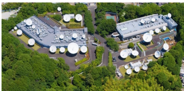
主局 横浜衛星管制センター（YSCC：Yokohama Satellite Control Center）：東経85度～169度までの衛星を指向する大小のパラボラアンテナ群、直径4m以上の大型アンテナは計29基 ※3
