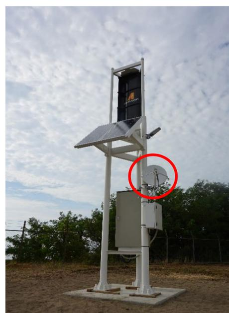
【写真：アストモスエネルギー金沢ターミナルに設置された「次世代マイクロ風力発電機」
